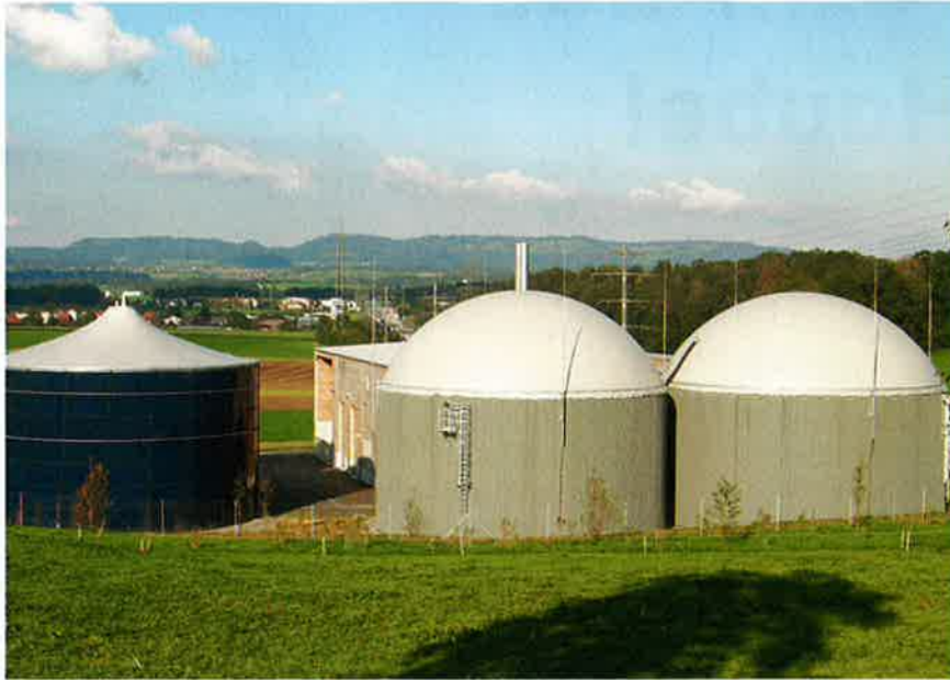
In Hünenberg im Kanton Zug liefert ein Holzheizwerk (Hintergrund) und eine Biogasanlage Wärme für ein Fernwärmenetz.
